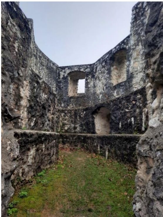
Slika 3: Notranjost obrambnega stolpa
