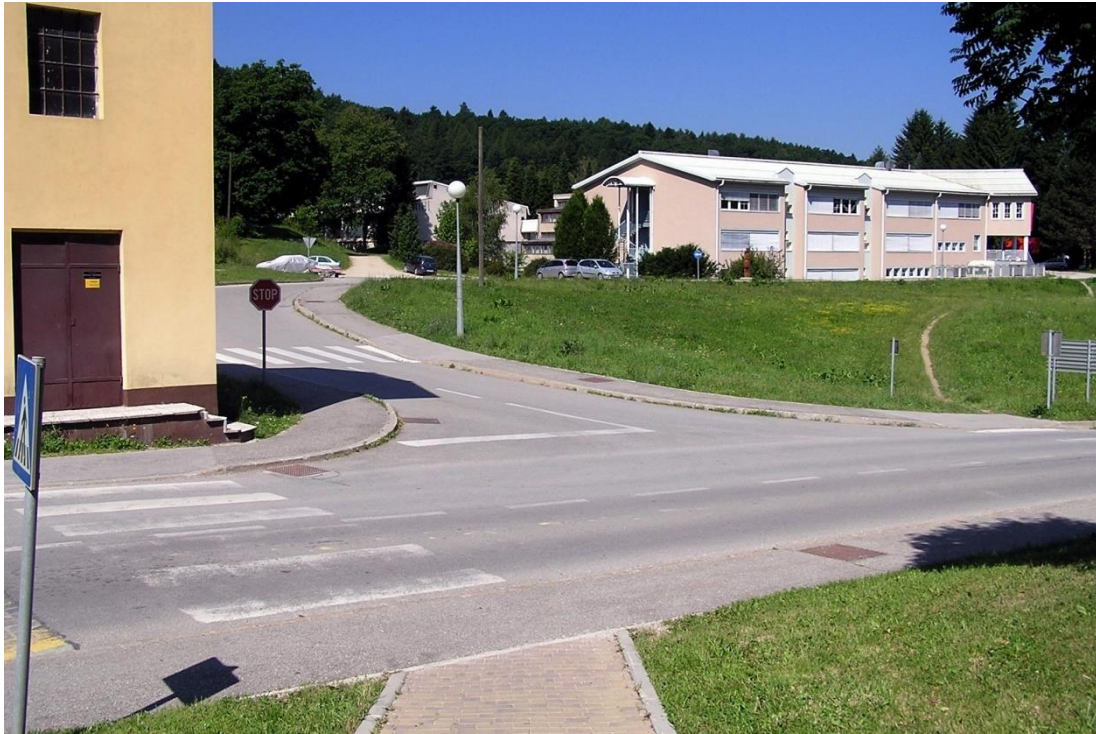
Fotografija 10: Križišče Čečovje – šola (pri transformatorju)
