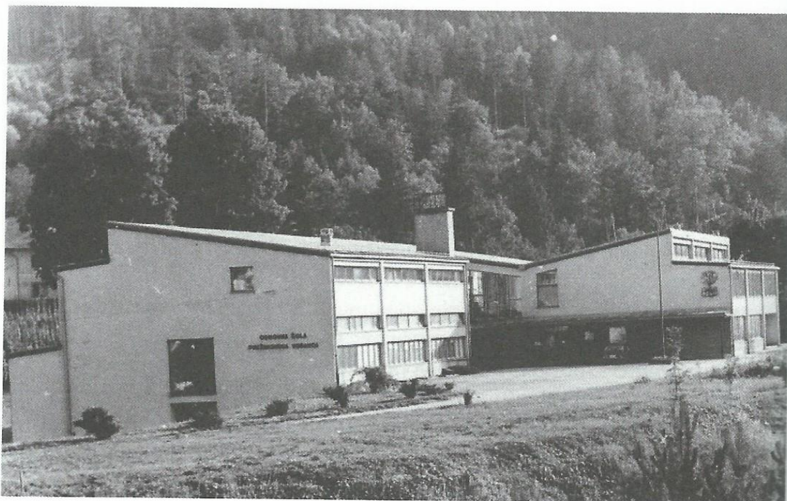
Novo poslopje OŠ Prežihovega Voranca Ravne na Koroškem, katerega otvoritev je bila 27. 11. 1966
