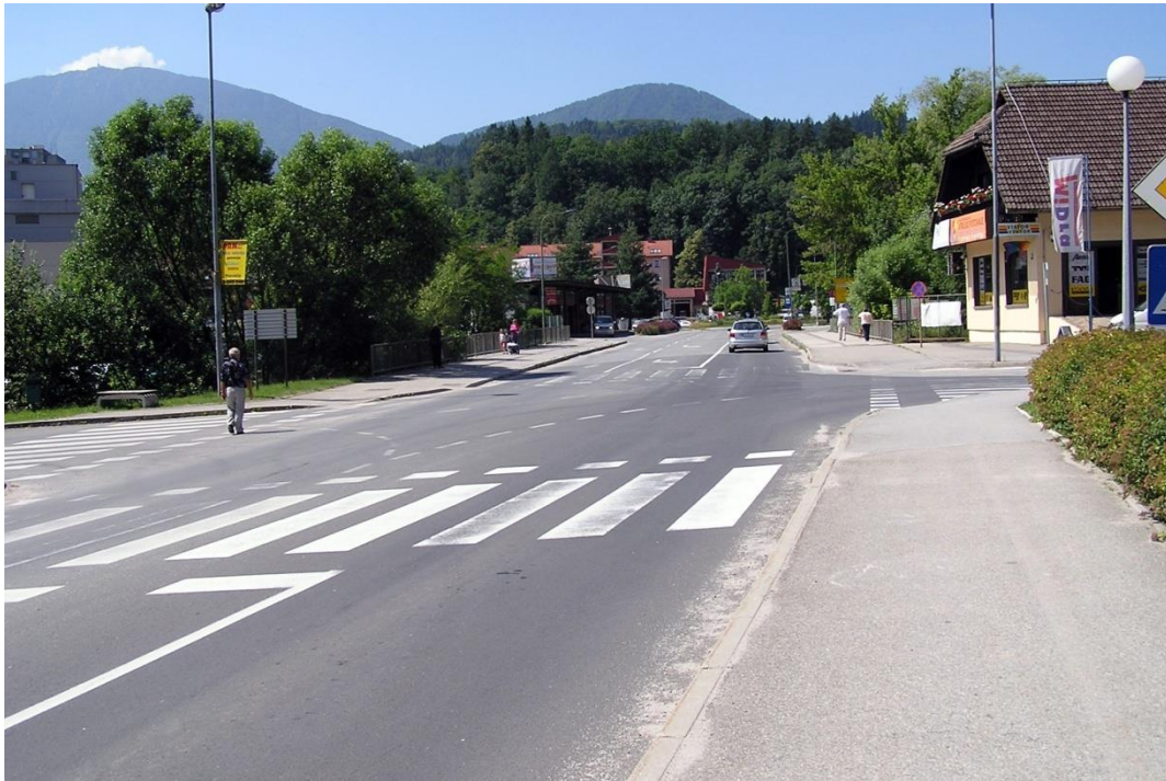
Fotografija 4: Križišče pri mostu čez reko Mežo pri trgovini Spar
