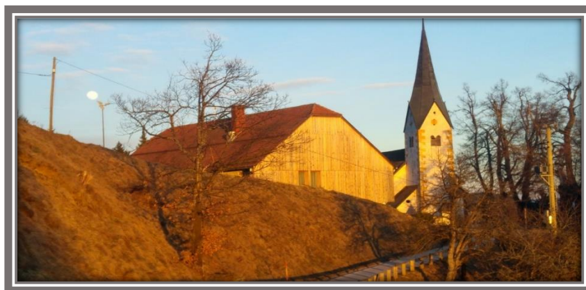
Slika 53: Strojanska cerkev in del obnovljenega poslopja nekdanje osnovne šole.
