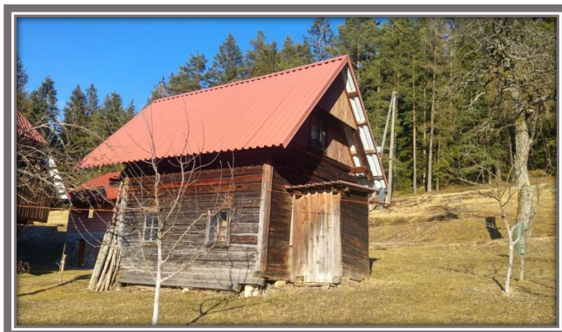
Slika 50: Kašča, prekrita s sodobno kritino.
