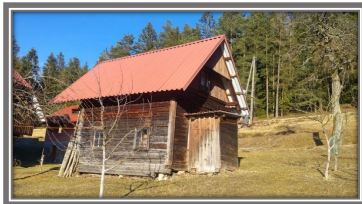
Slika 50: Kašča, prekrita s sodobno kritino.
